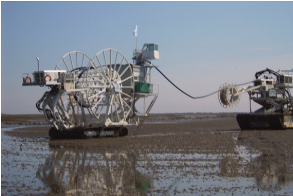
2010 wird eine neue Wasserleitung von Cuxhaven nach Neuwerk im Watt verlegt.
