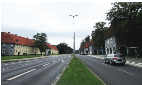
Foto: K 30 Bruchmachersenstraße in Lebenstedt, Fahrbahnzustand gut
